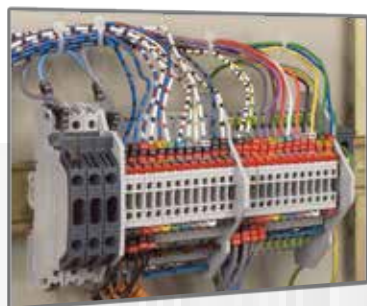
► Usporiadanie káblových zväzkov pomocou vyvážovacích pásovk
